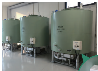
樹脂ライニングタンク型 クーリングタンク (複数台接続可)
