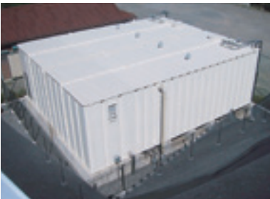
204 m ポンプ室付受水槽
