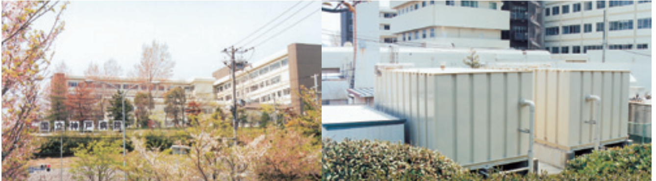
63m 3 ×2基=126m 3 受水槽
