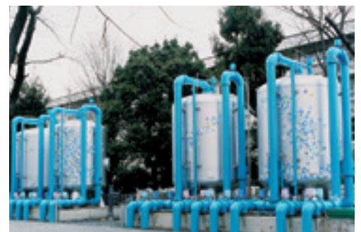
浄水場濾過槽
